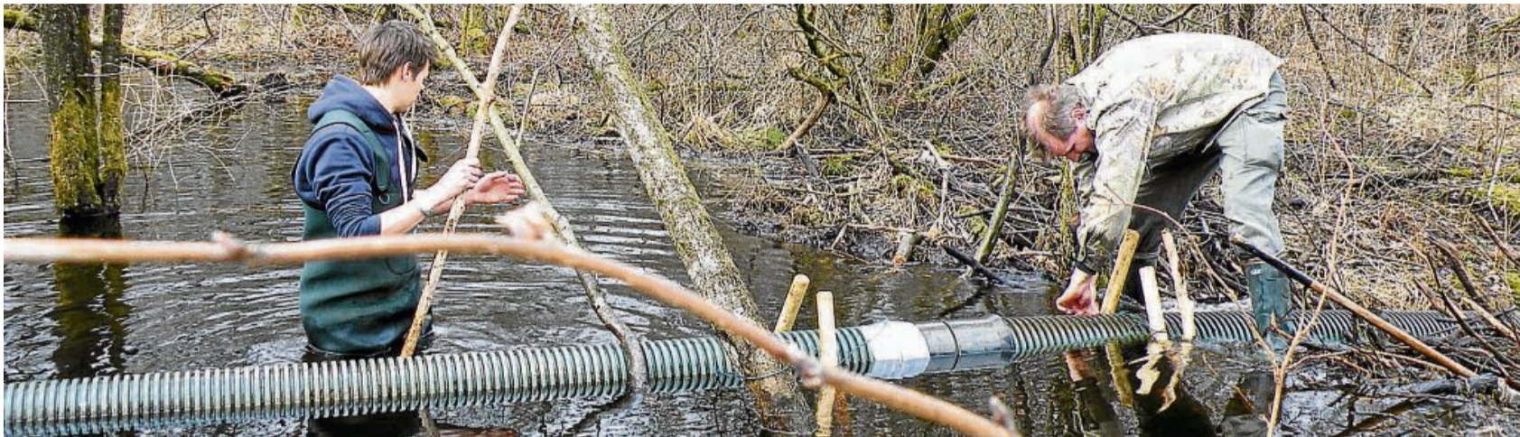
Der Damm muss durchbrochen werden: Die Naturschutzwächter Christoph Rzymbowski und Günter Schön haben einiges zu tun, um mit einem Rohr den Damm biberfest zu machen.
